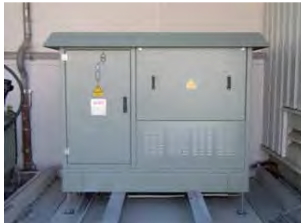
2 NOSPE-Widerstände in einer Betonstation 30kV, 2000A, 10s mit motorbetriebenen Lasttrennschaltern zur Sternpunktterdung an zwei Transformatoren
