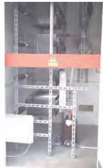
2 NOSPE-Widerstände in einer Betonstation 30kV, 2000A, 10s mit motorbetriebenen Lasttrennschaltern zur Sternpunktterdung an zwei Transformatoren
