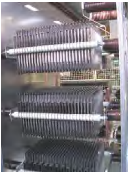
Filterwiderstand 33kV 2x 214 Ohm, 60 Hz 2x 65 kW dauernd 2x 6 MW für 1,5 sec.
