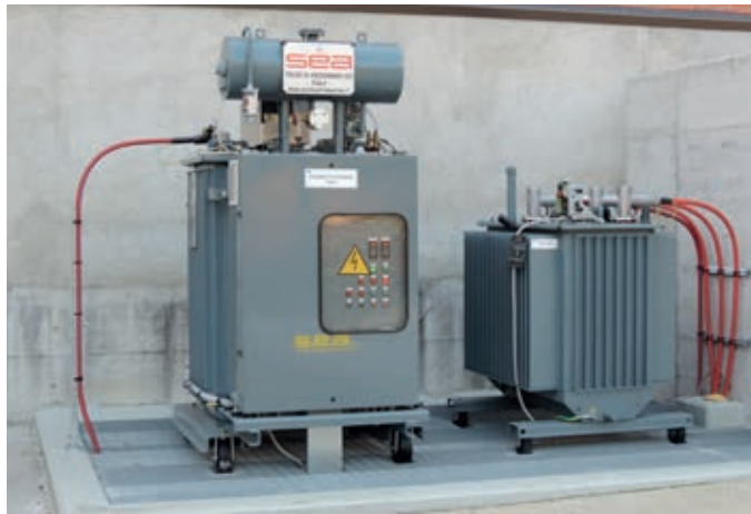
Kombination aus Sternpunktbildner und Tauchkernspule in zwei Kesseln
