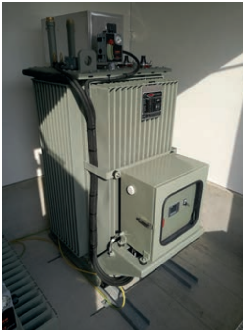
Tauchkernspule in Hermetikausführung
