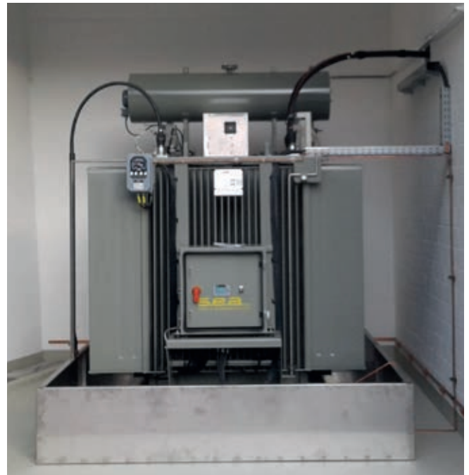
Tauchkernspule Ausführung mit Ausdehngefäß
