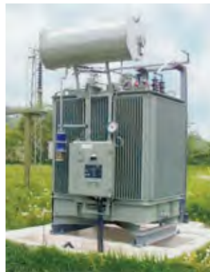
Erschlußlöschspulen Erdschlußlöschkombinationen
