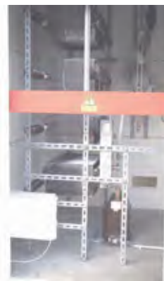
2 NOSPE-Widerstände in einer Betonstation 30kV, 2000A, 10s mit motorbetriebenen Lasttrennschaltern zur Sternpunktterdung an zwei Transformatoren 2 earthing resistors in a substation 30kV, 2000A, 10s with load break switches with motor drives for 2 transformers
