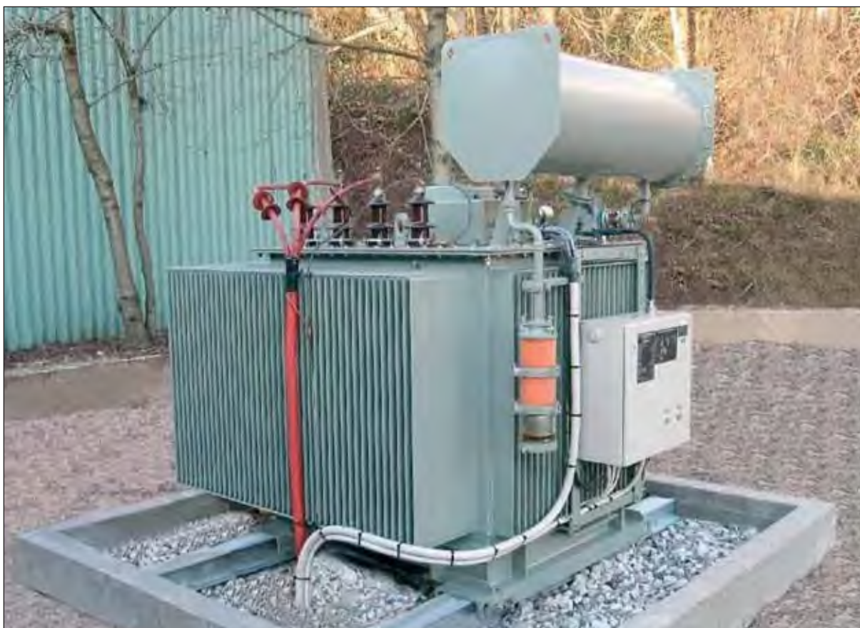
Abb. 1 10kV/160A Erdschlusslöschkombination für Dauerbetrieb
